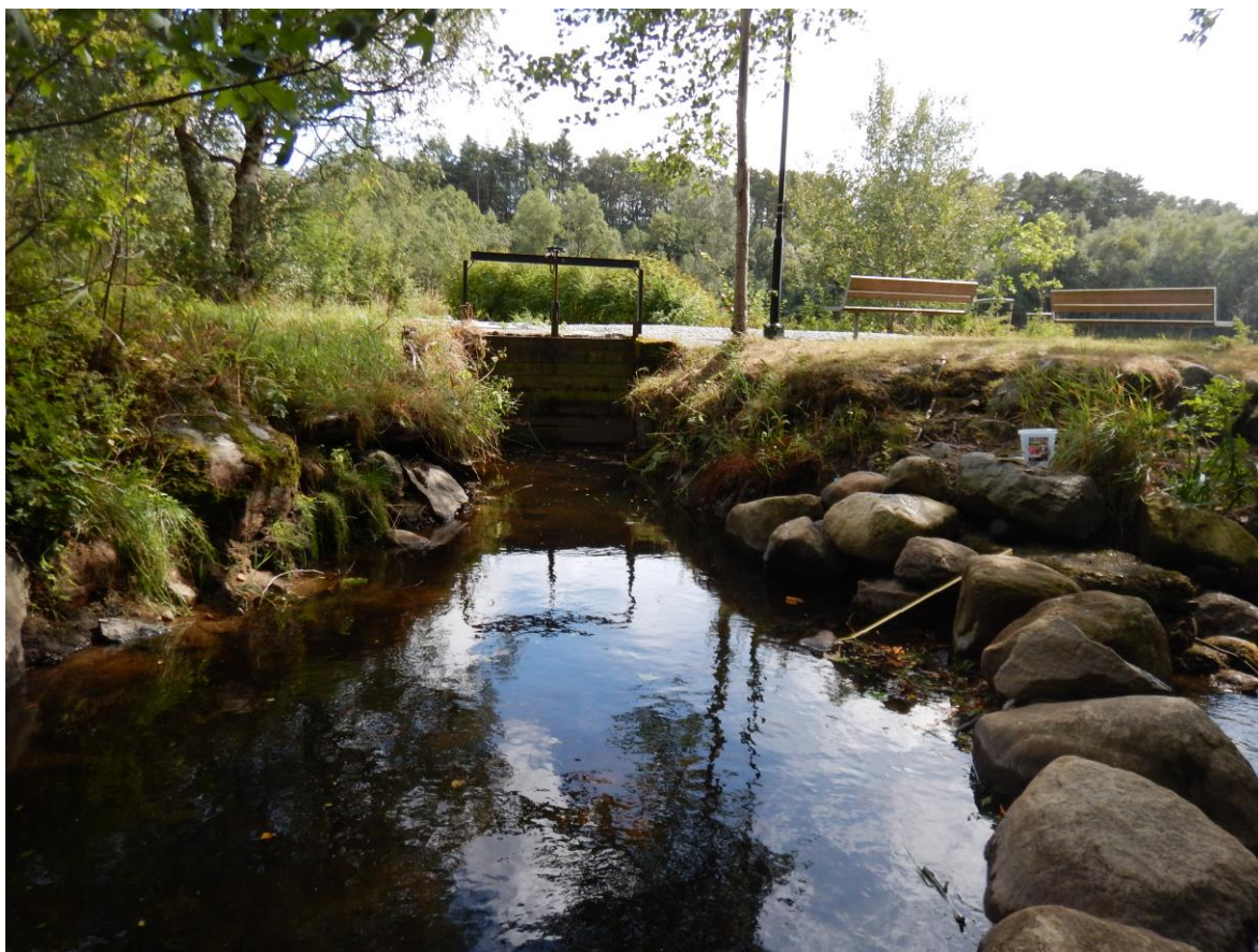
Figur 2.1. Justerbar luke som kan regulere vannoverføringen til Stemmen. Steinterskelen som går ut i Frøylandsbekken er synlig nede til høyre i bildet.
