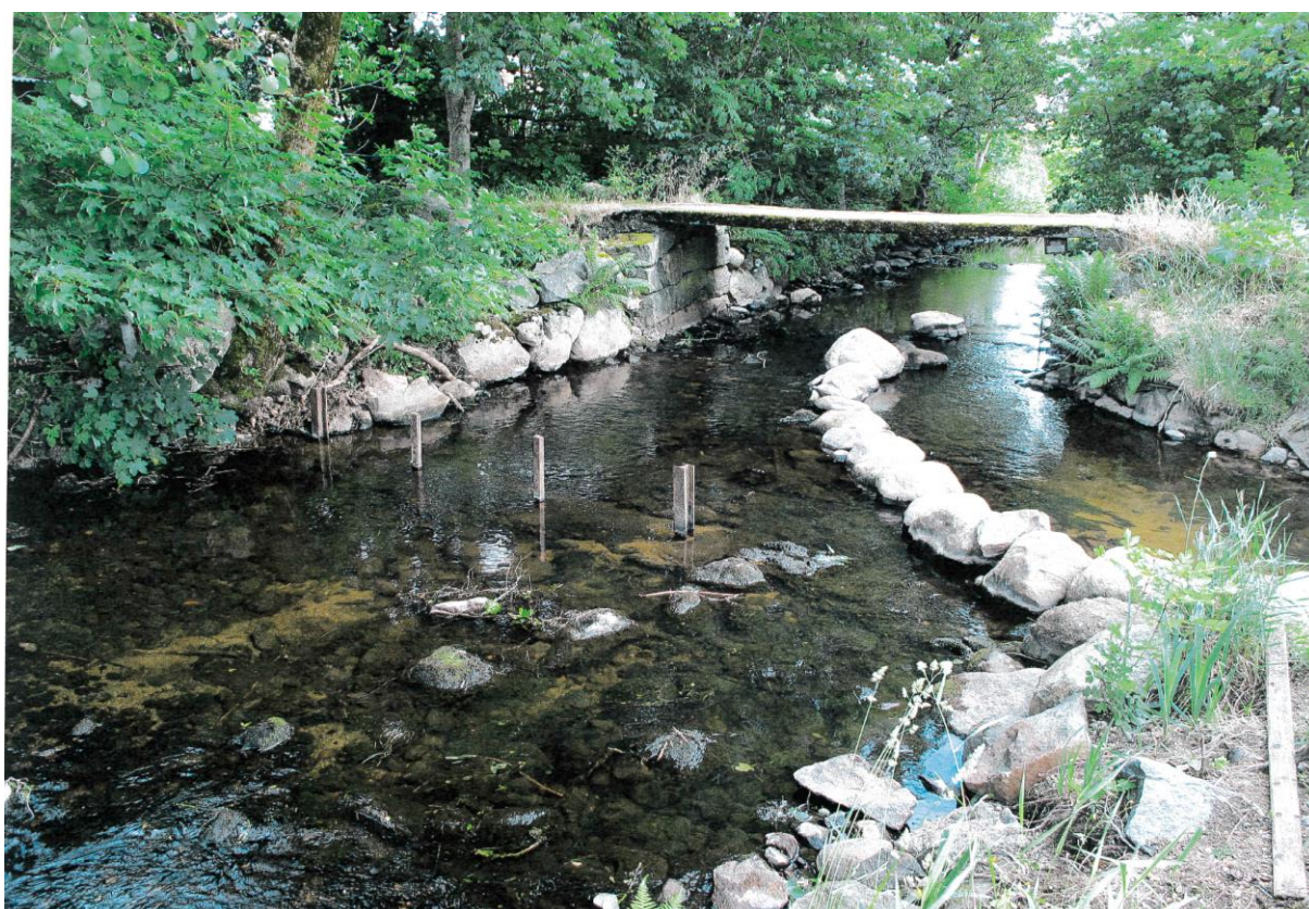
Figur 1.3. Frøylandsåna med innløpet til kanalen til Stemmen til høyre i bildet. En støpt betongterskel med jernbalker som står igjen i hovedløpet er rester av den gamle demningen. I 2016 la kommunen ut en steinterskel i elva for å lede mer vann til Stemmen, framfor alt ved små vannføringer.
